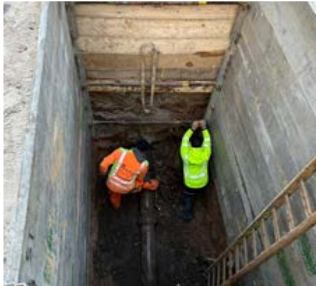
Gravenbruchstraße 21-31, Dreieich // AR
