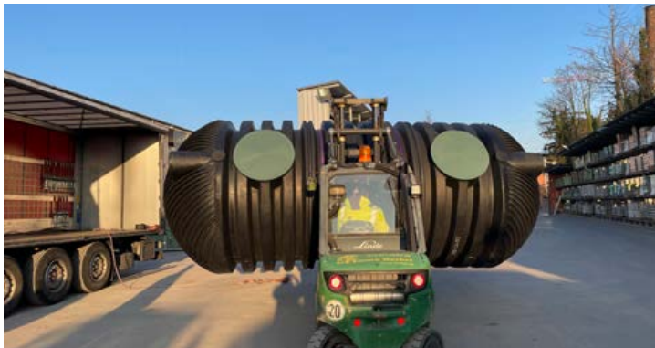
Verladung der Retentionszisterne
