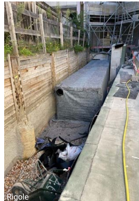
Verlegung WRB 170 (Daueranstau)
