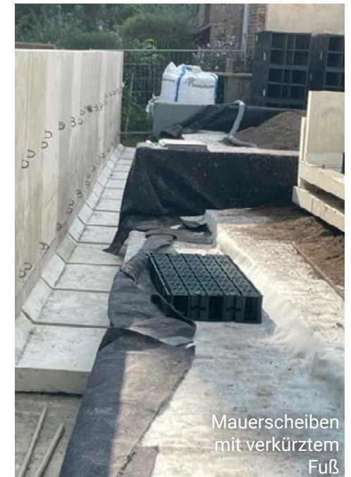
Kontrollschächte RSA 54R, eingedichtet in Retentionsfläche
