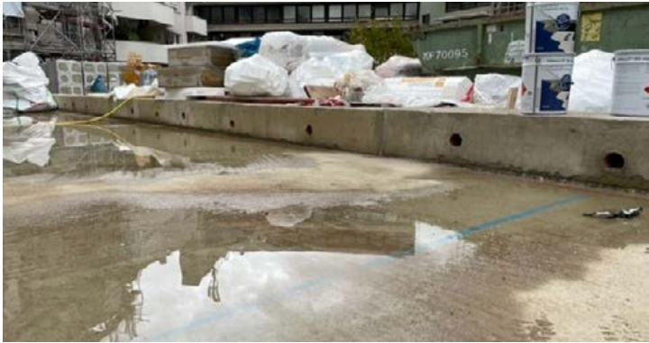
Überzug mit Durchflutungsdurchbrüchen
