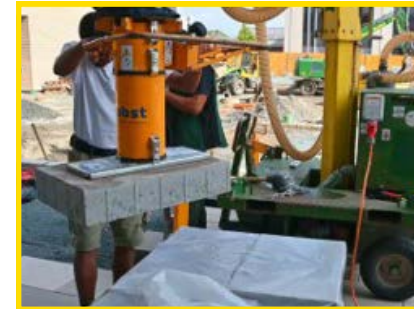
Vakuum-Verlegemaschine für schwere Bauteile
