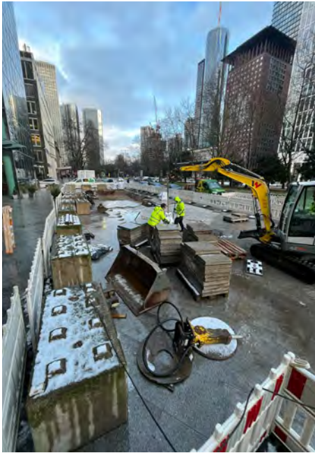
EZB Gallusanlage, Frankfurt
