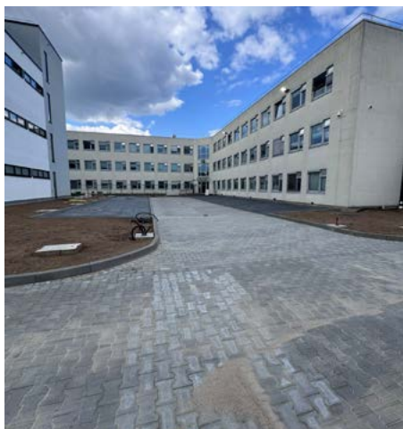
Tor 32, Fraport – Gebäude 587
